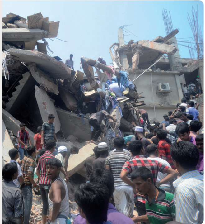
Figure 1 Photo de l'effondrement du Rana Plaza
