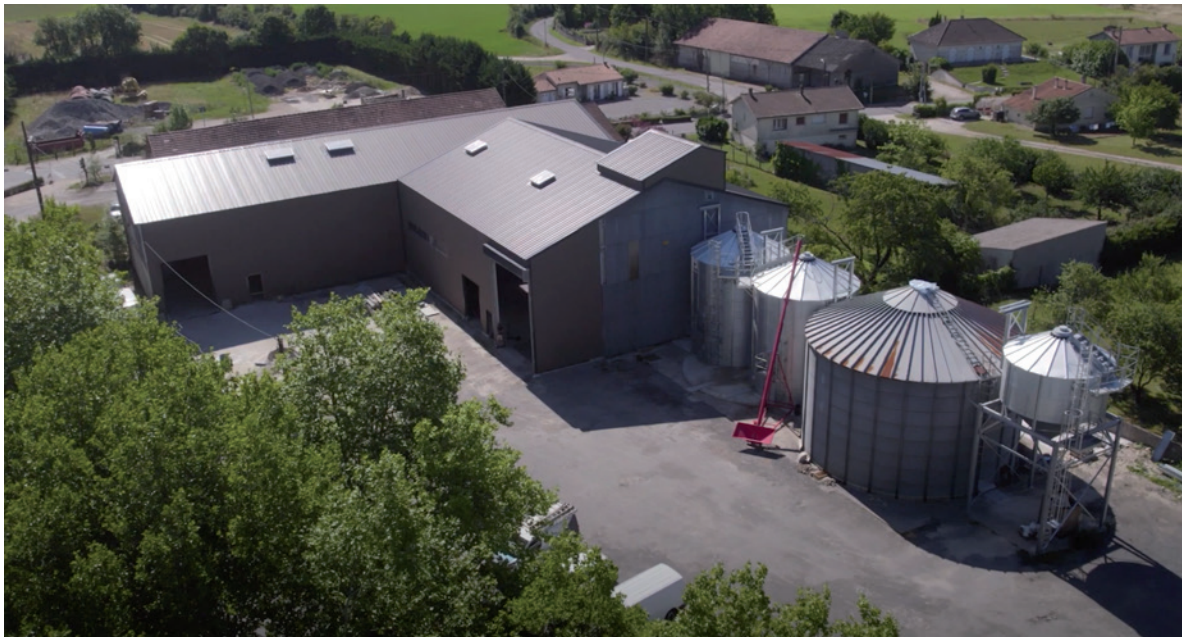
Nouvelle unité de stockage et de transformation des fermes de Chassagne
